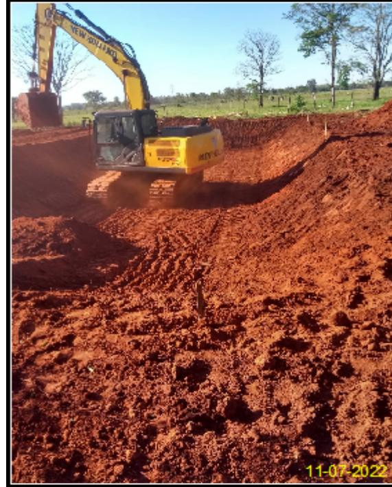
**Foto 01** – Vista geral da construção do Tanque Escavado para Piscicultura.
