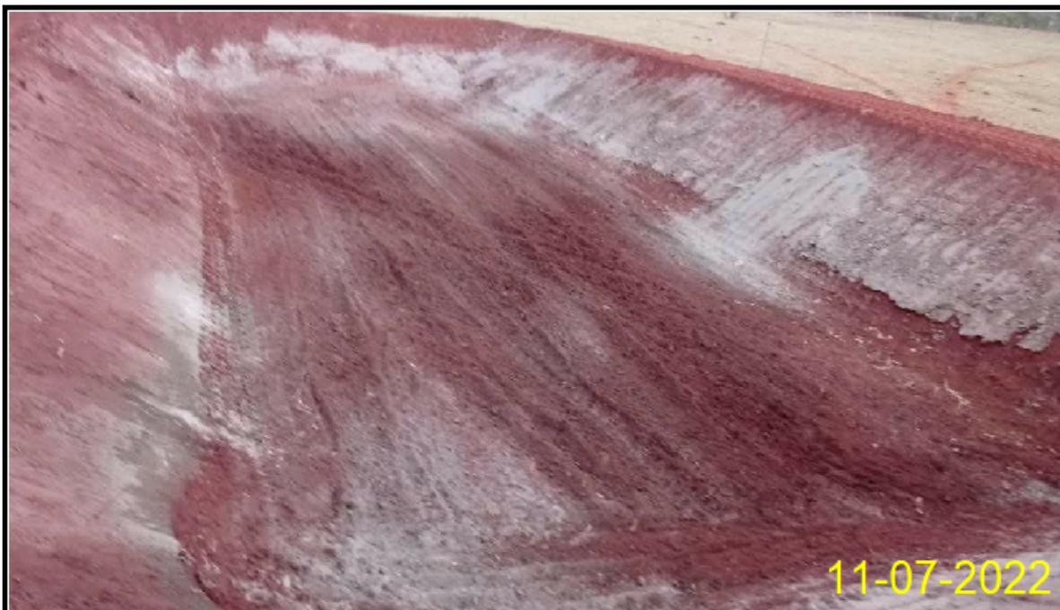
**Foto 06** – Vista geral do Tanque Escavado onde foi realizado a calagem, logo após a construção do viveiro, antes de iniciar o primeiro cultivo para corrigir o pH do solo ou parâmetros da água.
