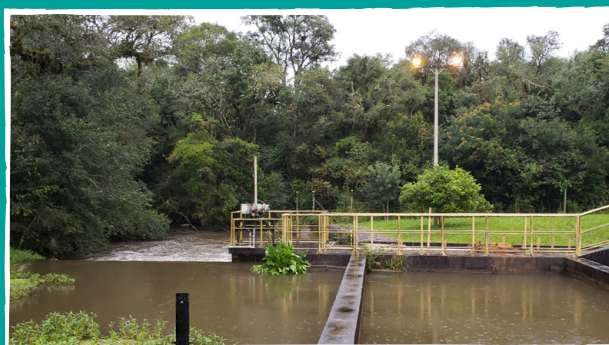
Estação de Tratamento de Água do Miringuava em condições normais (28/05/2019)
